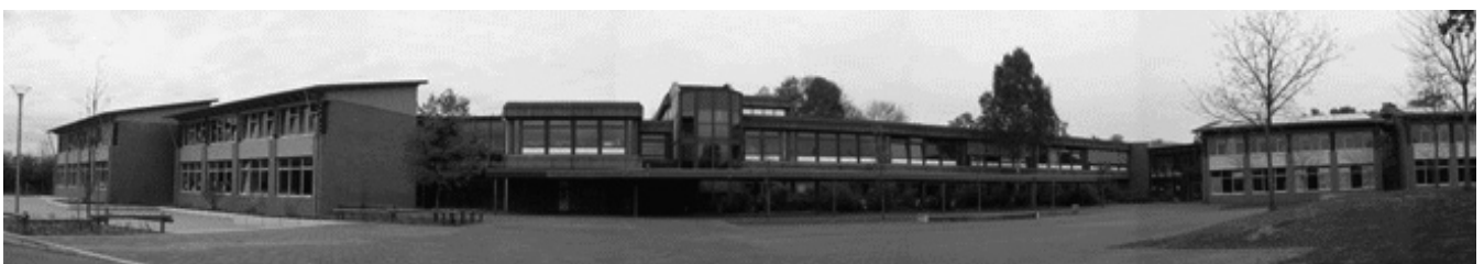
Abb. 1: Geschwister-Scholl-Schule in Gütersloh
